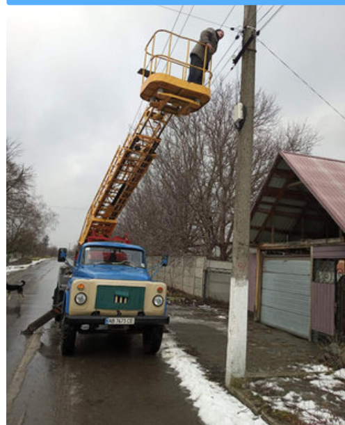
Встановлення ліхтарів вул. Б.Хмельницького
